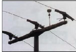
Al fine evitare elevati fattori di rischio per l'avifauna, occorre rispettare alcune dimensioni nella struttura dei tralicci, soprattutto la distanza tra cavo e palo.
